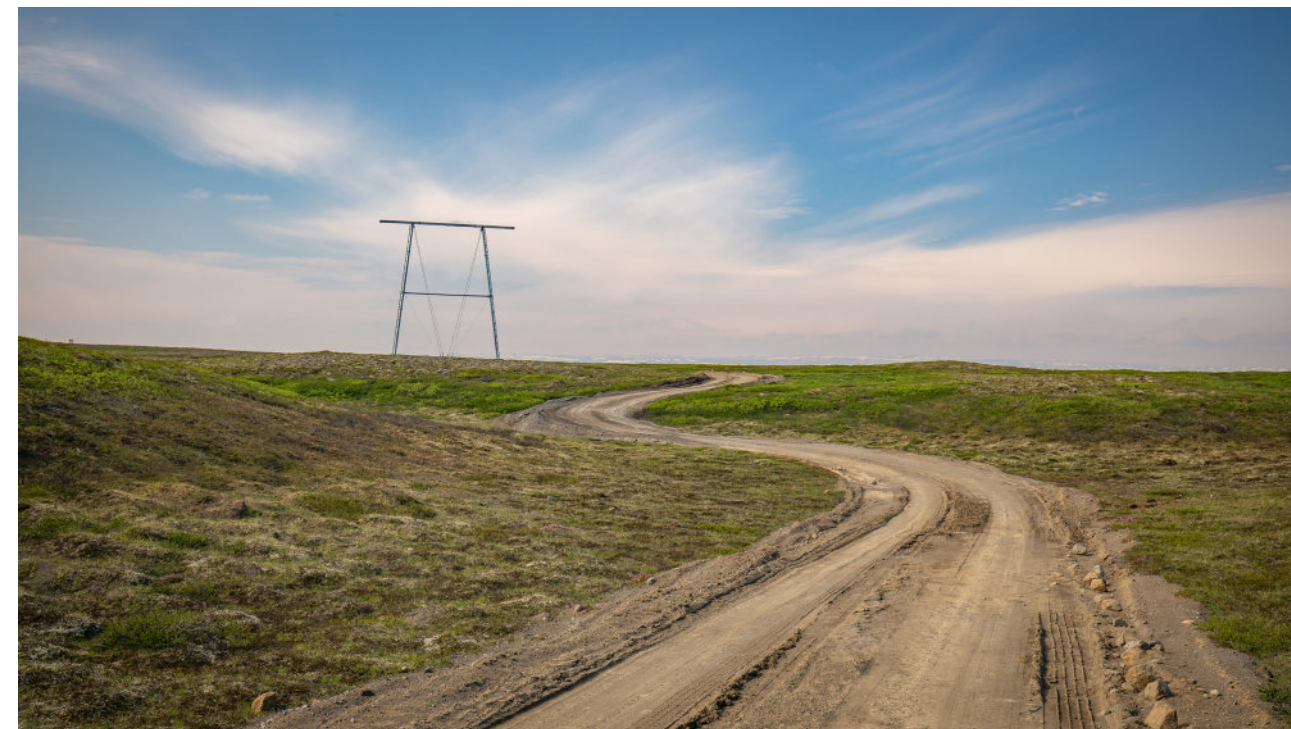
Dæmi 3. Nýleg línuslóð meðfram Hólasandslínu 3
